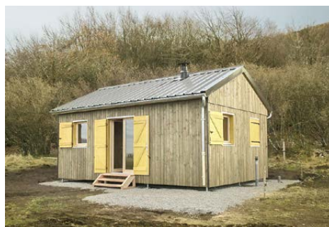
Construction et aménagement d'une cabane de berger © Jodie Way
